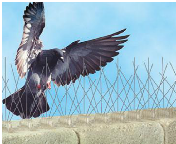
Ανοξείδωτες αιχμές για αποτροπή της φωλεοποίησης (πηγή: antipalomas.info)
